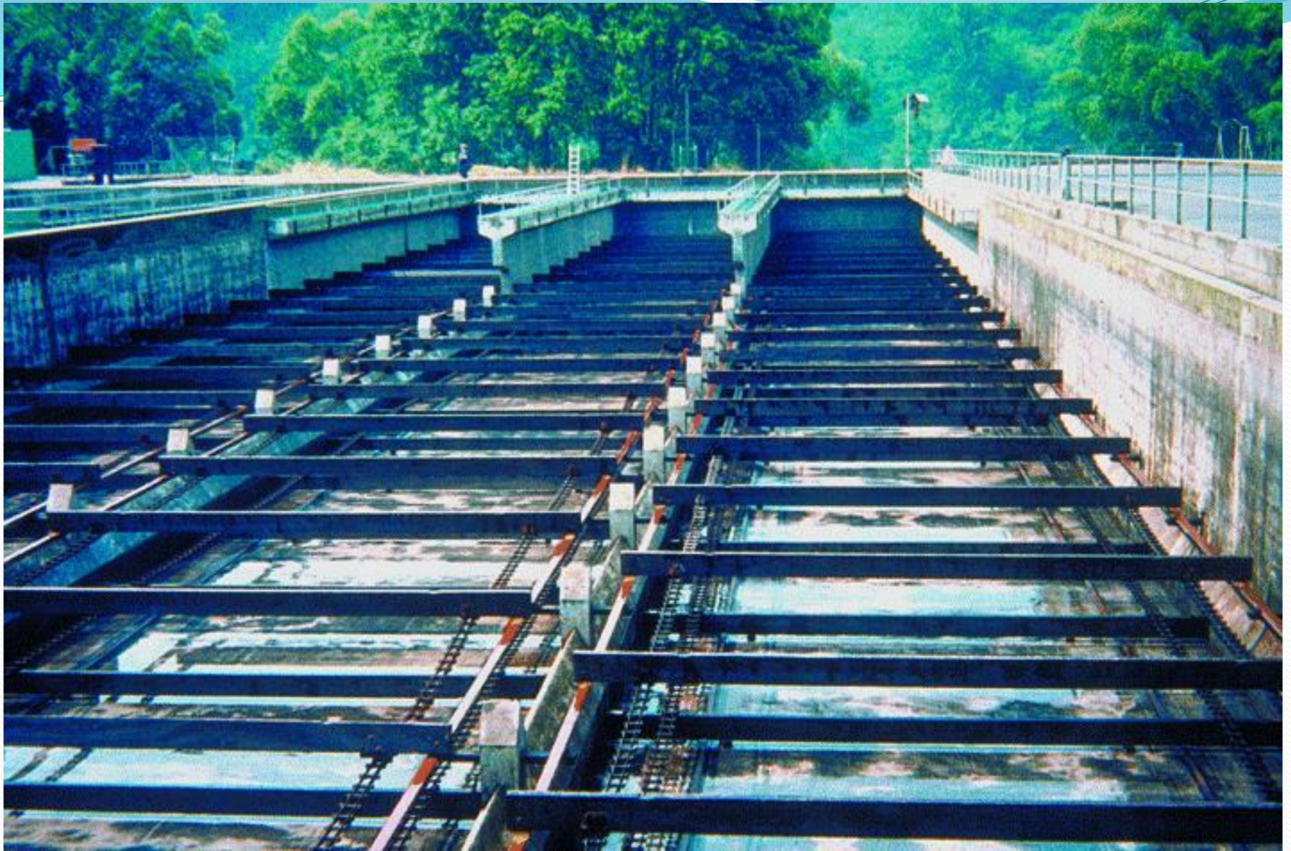
Installation de AÏRE pour le traitement des effluents de GENÈVE (Suisse). Débit: 3,6 \text{ m}^3/\text{s} . Un des 8 décanteur à chaînes de 70 \text{ m} \times 18,5 \text{ m} .
