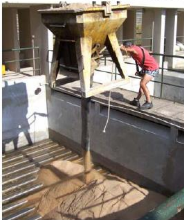
Chargement du sable
