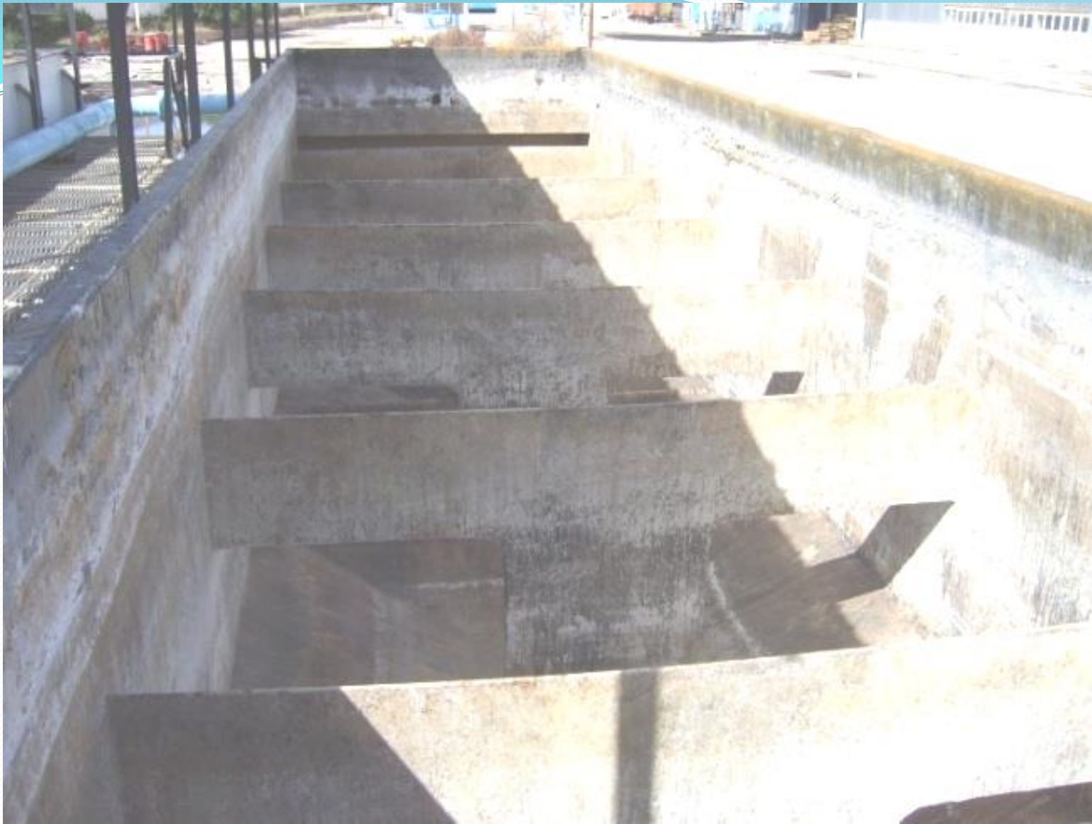
Décanteur statique à plusieurs compartiments
