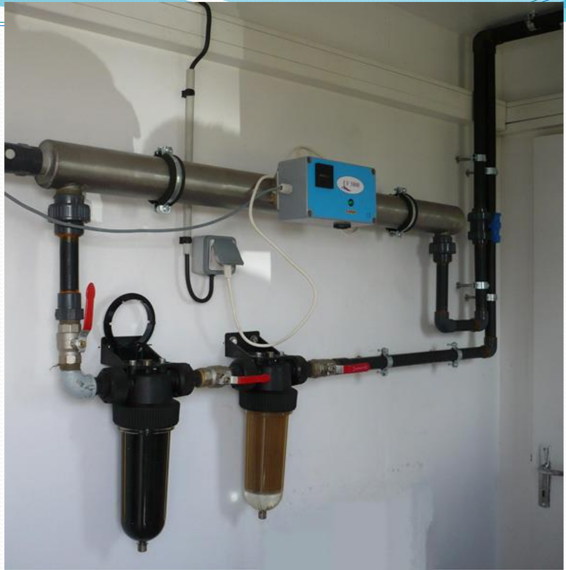
Installation de désinfection par UV
