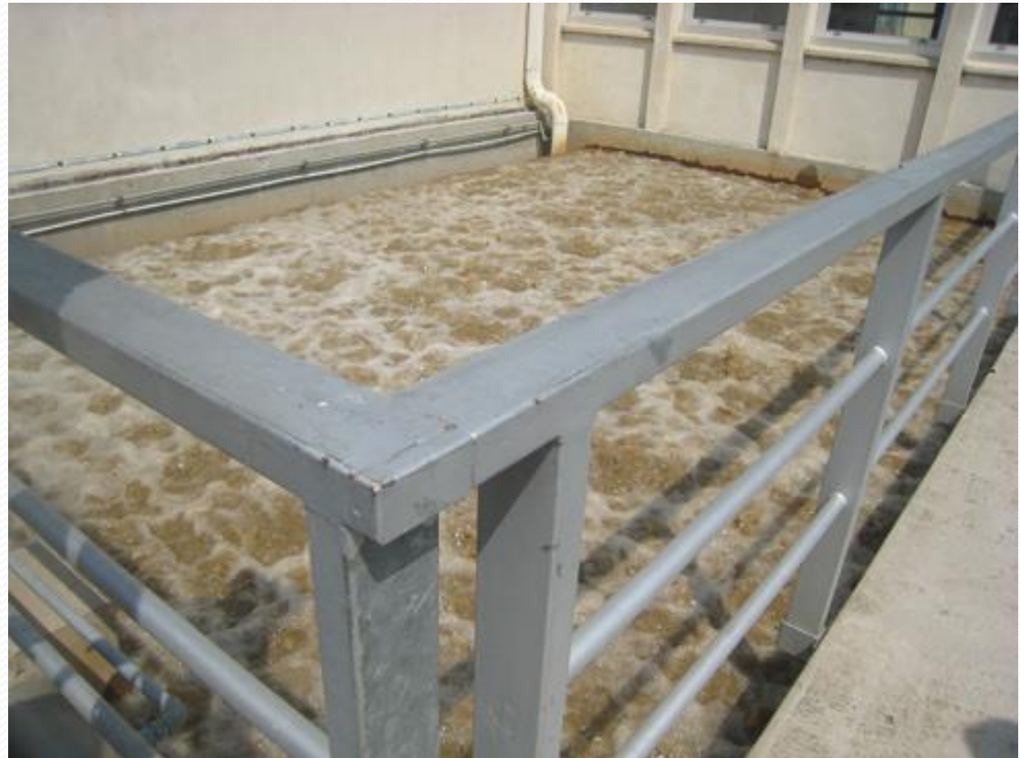
Lavage d'un bassin de filtration rapide
