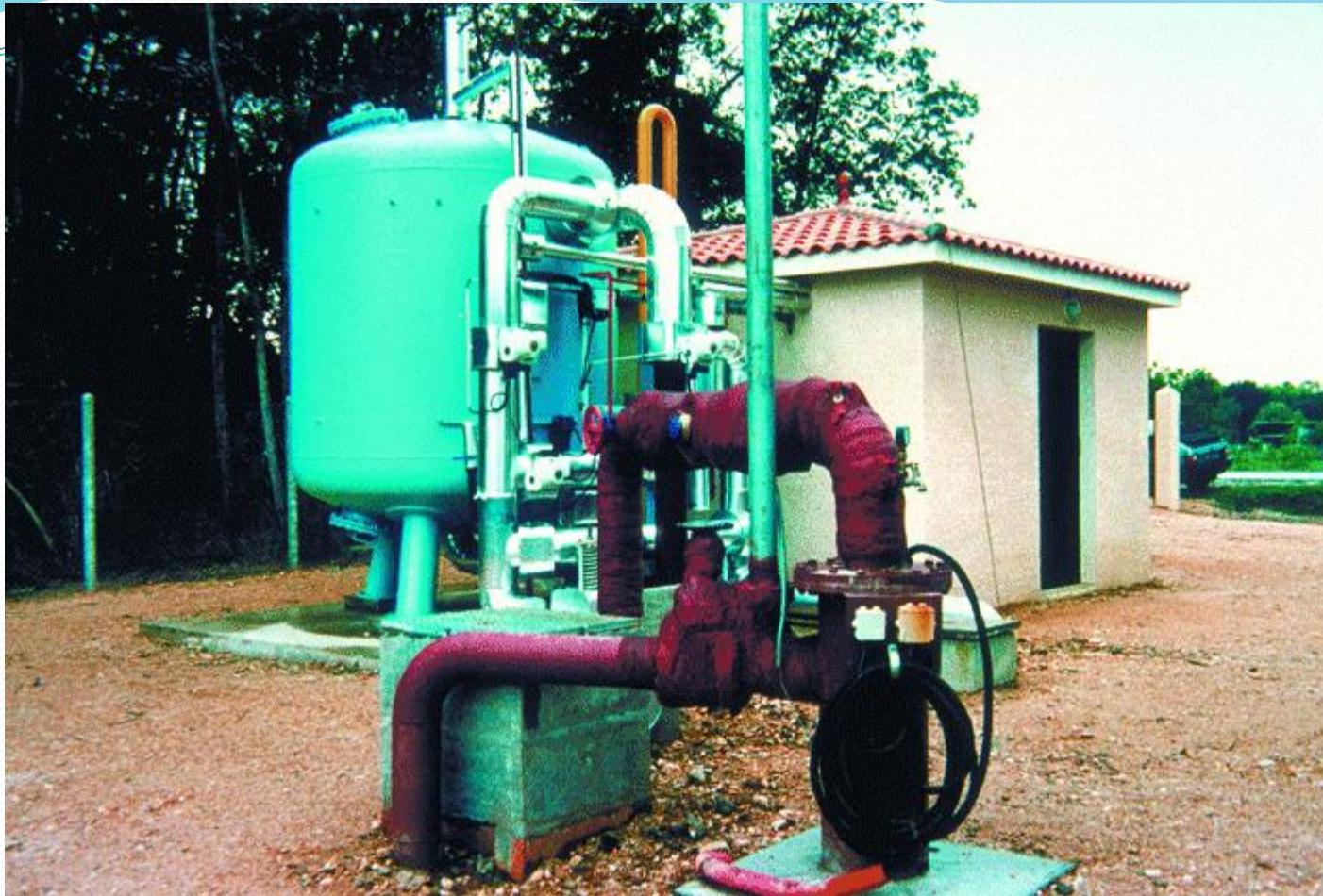
Installation de SABLENS-DE-GUITIES (Gironde). Débit: 100 \text{ m}^3 \cdot \text{h}^{-1} . Déferrisation biologique sous pression.
