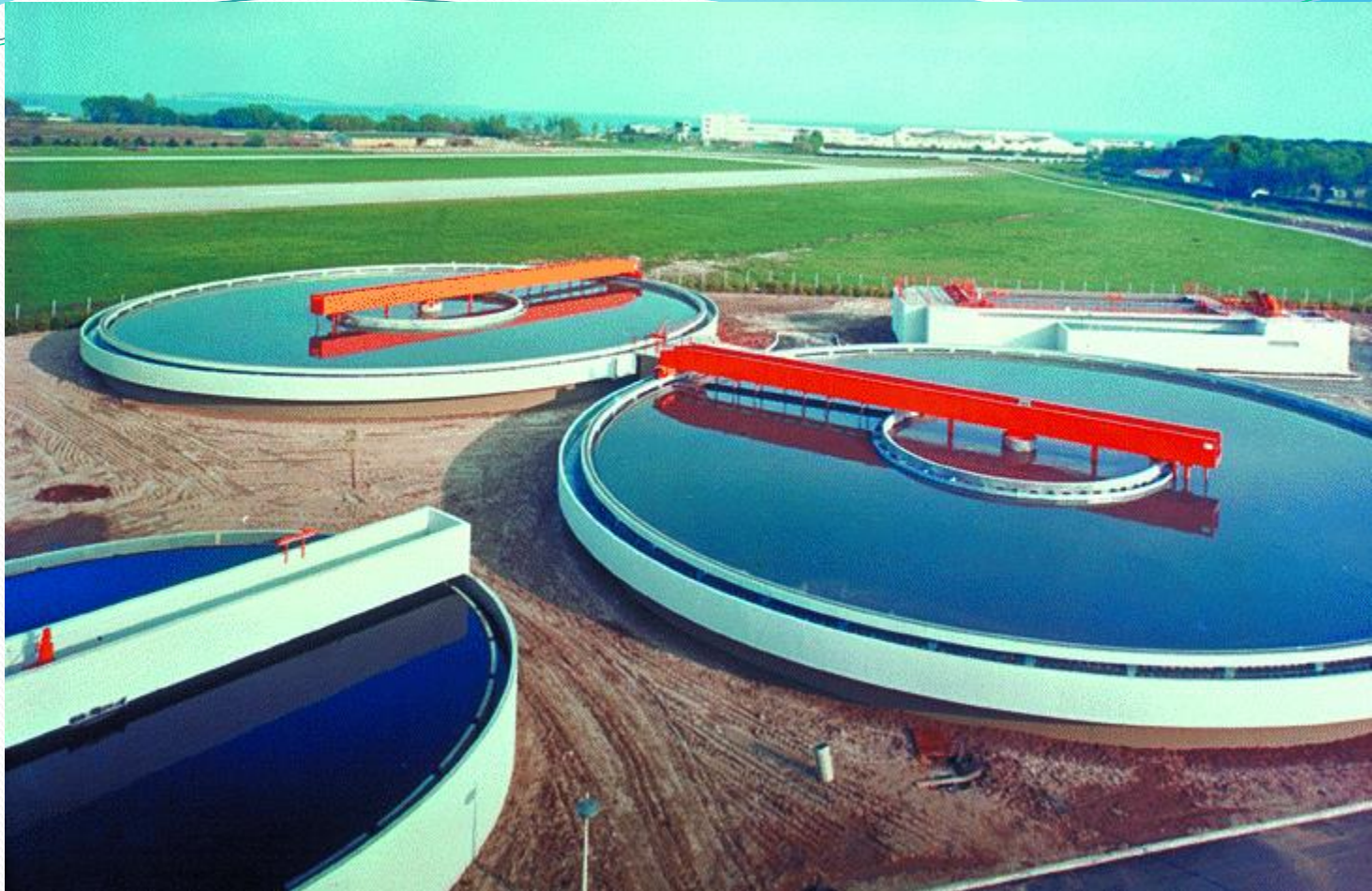
Installation de CANNES (Alpes-Maritimes). Débit maximum : 5500 m 3 /h. Décanteur-floculateur.
