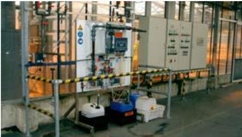
Installations au dioxyde de chlore dans le traitement de l'eau
