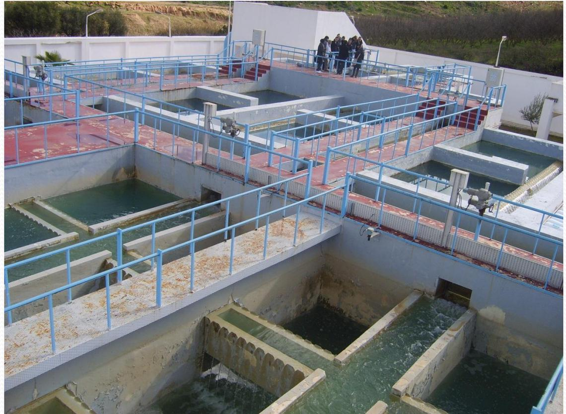
Cette aération est nécessaire lorsque l'eau présente une carence en oxygène et permet alors, soit :
