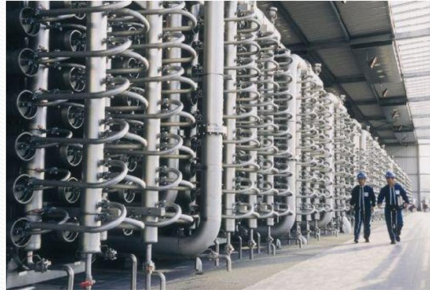
Toute installation de traitement doit être pourvue d'au moins deux unités de filtration ou plus pour une opération continue et sans interruption de service lors des travaux de d'entretien ou de réparation des filtres. Les unités de filtration doivent pouvoir traiter le débit journalier maximum de conception lorsqu'une unité de filtration est mise hors service et chaque unité de filtration doit pouvoir opérer indépendamment.
