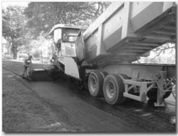
Nivellement et pré-compactage de l'enrobé
