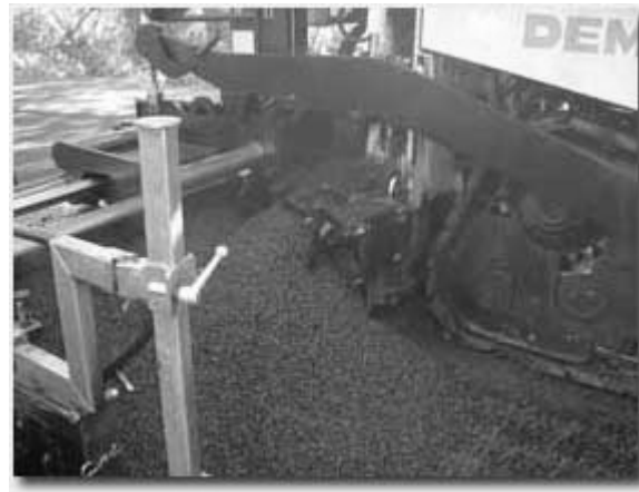
Répartition de l'enrobé sur toute la largeur de travail
