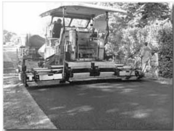
Nivellement et pré-compactage de l'enrobé
