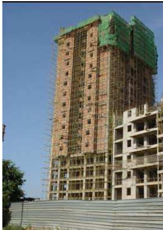
Fig. 4 Bâtiment avec voiles en béton armé, très bonne résistance à l'action sismique
