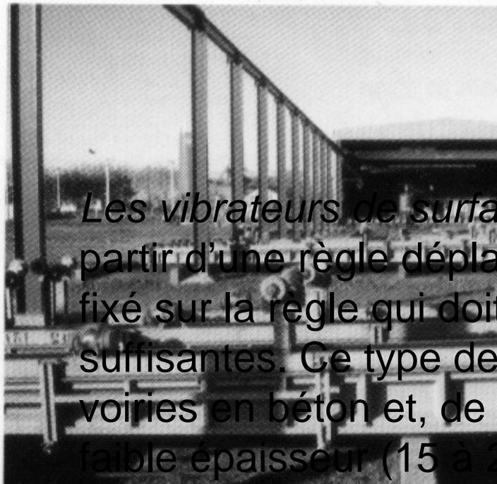
**Les vibrateurs de surface** : permettent de transmettre la vibration à partir d'une règle déplacée à la surface du béton. Le vibrateur est fixé sur la règle qui doit présenter une rigidité et une inertie suffisantes. Ce type de vibration est réservée aux dalles, aux voiries en béton et, de façon générale, à tout élément horizontal de faible épaisseur (15 à 20 cm au maximum).
