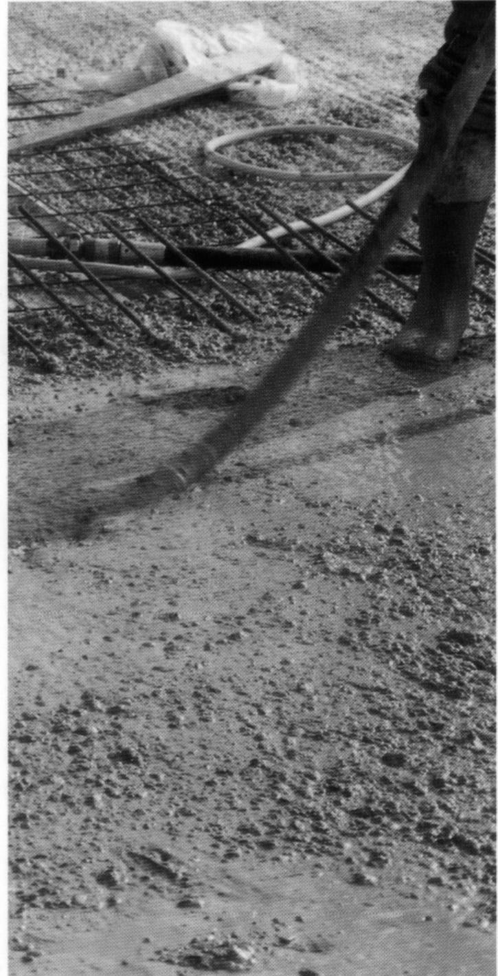
La vibration a aussi pour effet d'améliorer la viscosité du béton et par conséquent permet la réduction de la quantité de l'eau de gâchage dont une partie importante n'est pas nécessaire à l'hydratation du ciment, mais sert uniquement à rendre le béton plus plastique. Une vibration adaptée permet une mise en place efficace de bétons fermes contenant peu d'eau et qui, une fois durcis, ont l'avantage d'avoir une faible porosité.
