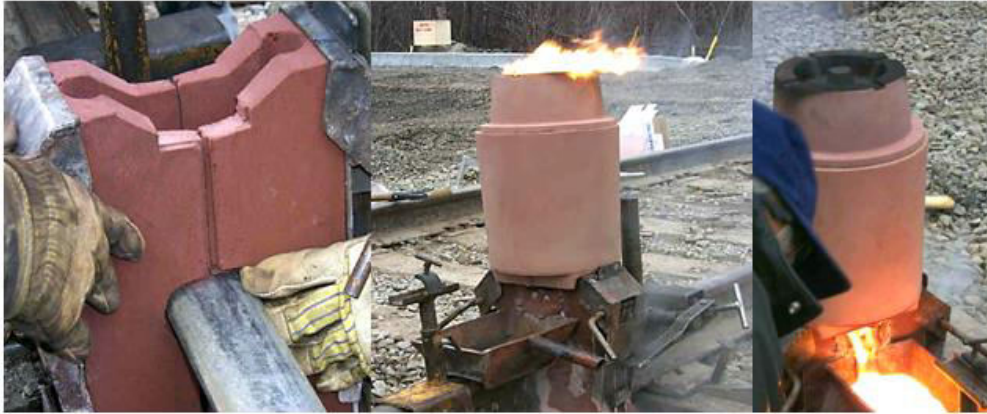
Figure 85 : Exemple de soudage des rails par aluminothermique
