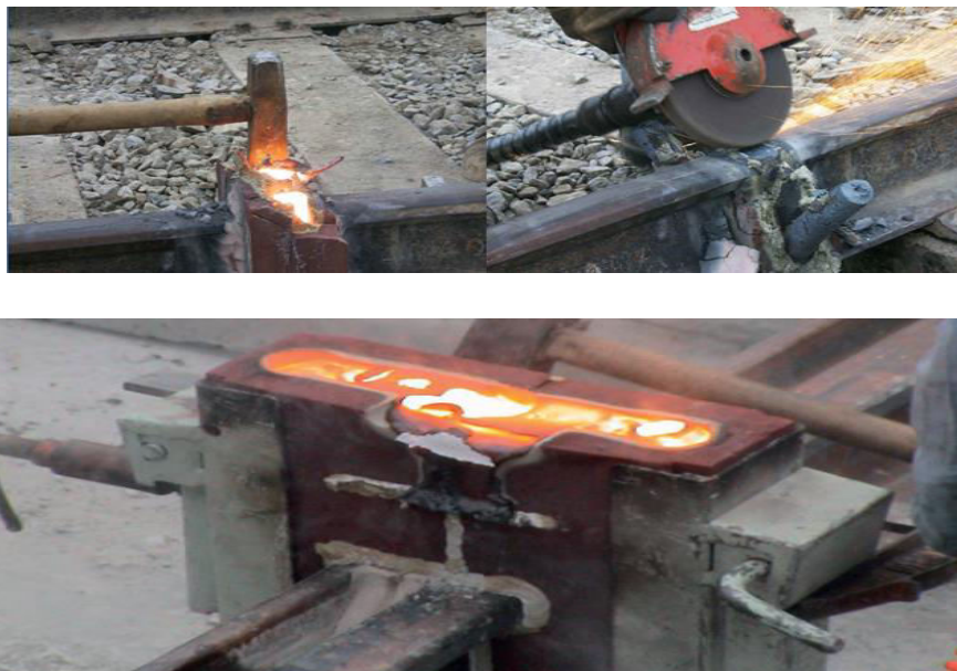
Figure 86 : Moulage de l'opération de soudage des rails par aluminothermique
